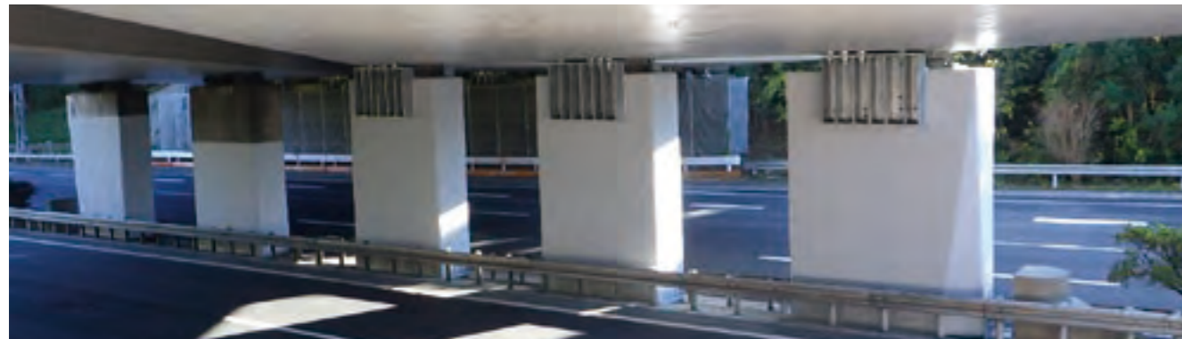
常磐自動車道 広岡橋跨高速道路橋耐震補強工事/東日本高速道路株式会社 発注/令和元年度 優良工事事務所長表彰
