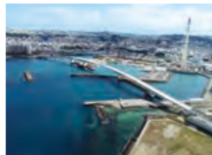
平成27年度牧港高架橋上部工(P4~P6)工事/ 2017年竣工/内閣府沖縄総合事務局開発建設部 発注
