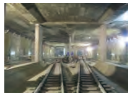
ジャカルタ高速鉄道建設工事 CP106工区／2019年竣工／ジャカルタ高速鉄道株式会社 発注
