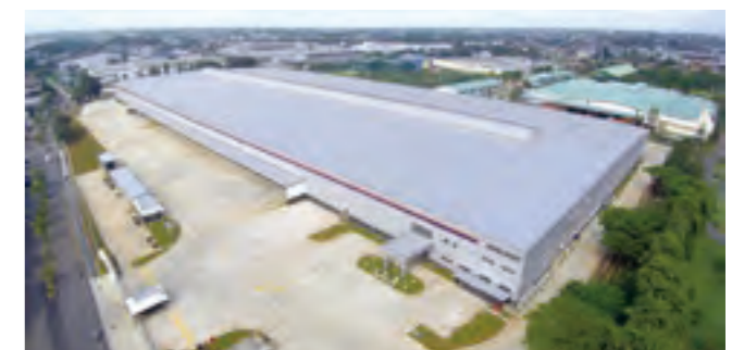
NEX LOGISTICS INDONESIA (日本通運) 新倉庫建設工事(インドネシア)
