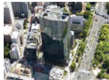
住友不動産御成門タワー/2018年竣工/ 住友不動産株式会社 発注
