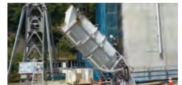
コンクリート打設用大型バケツ
