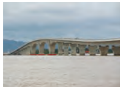
ディンブー・カットハイ橋(ラックフェン港連絡路)／2017年竣工／ベトナム政府運輸省 第2事業管理局 発注
