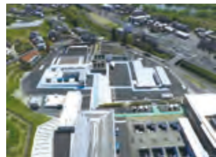
小田中浄水場更新事業/2016年竣工/ 岡山県津山市水道局 発注
