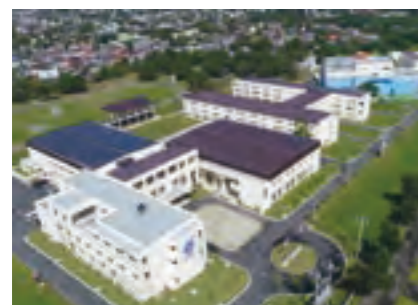
商船三井商船大学建設工事／2018年竣工／MOL マグサイサイ・マリタイム・アカデミー (株式会社商船三井 フィリピン現地法人) 発注
