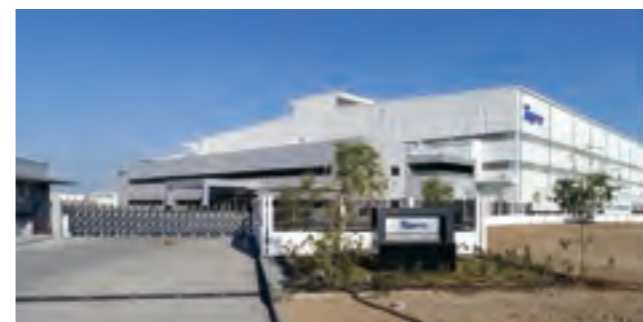
東プレ株式会社 グジャラートプレス工場建設工事(インド)
