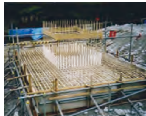
アラミドロッドを使用した受電用引留鉄構基礎
