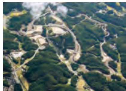
内陸用地造成事業 豊田・岡崎地区 中工区 整地工事/ 2017年竣工/愛知県企業庁 発注
