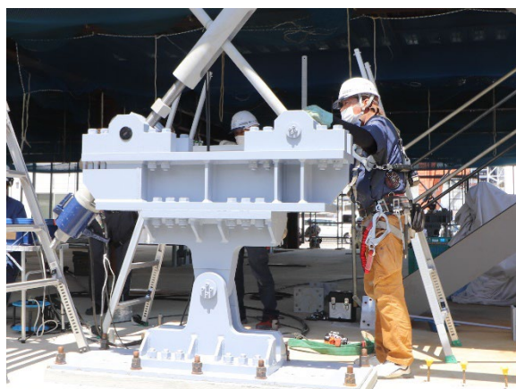
【揺動機構部の設置作業】
