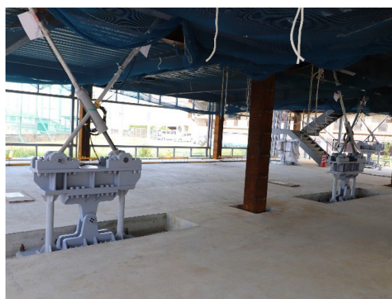
【揺動機構部の設置状況】
