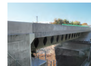
全長26.5mの別墅谷橋。比較的短い橋で工事を行い、Dura-Bridge（デュラブリッジ）の施工面、コスト面、安全面での課題を確認しています。将来的には、300～500m級の橋への展開を目指しています。
