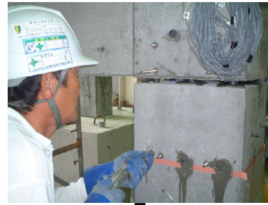
(3) 下階PCa柱, 鉄筋継手部 モルタル注入
