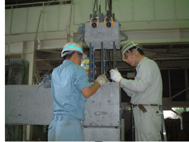
(2) 上階PCa柱のセット
