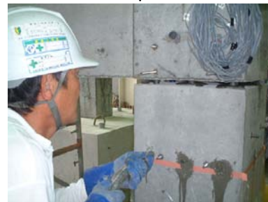
(3) 下階PCa柱, 鉄筋継手部 モルタル注入
