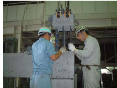
(2) 上階PCa柱のセット
