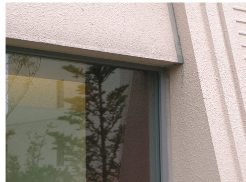
写真-3 B建物 外壁面の状況
