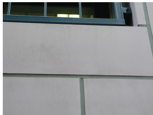
写真-8 F 建物 外壁面の状況
