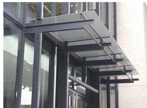
写真-4 C建物 外壁面の状況
