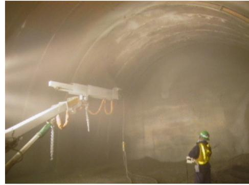
写真-6 エア吹付け方式による粉じん発生状況
