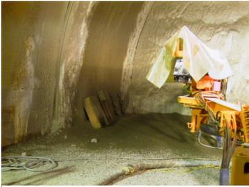
写真-7 付着強度試験供試体採取
