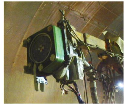
写真-2 遠心力吹付け装置
