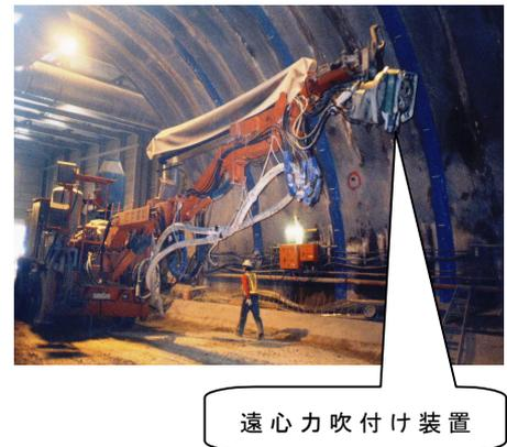
写真-1 遠心力トンネル吹付け機
