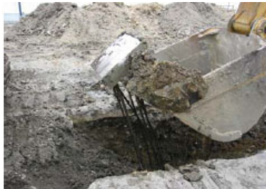
写真-3 基礎撤去状況
