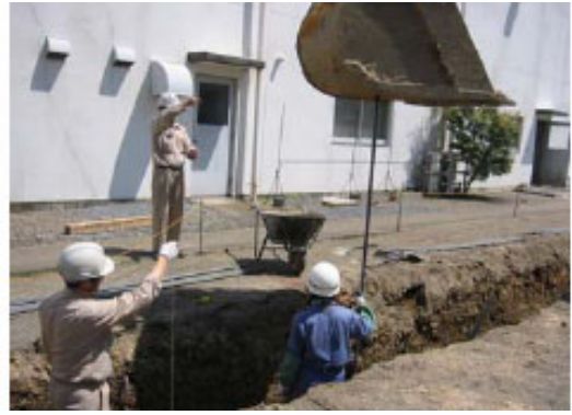
写真-2 杭部材打設状況
