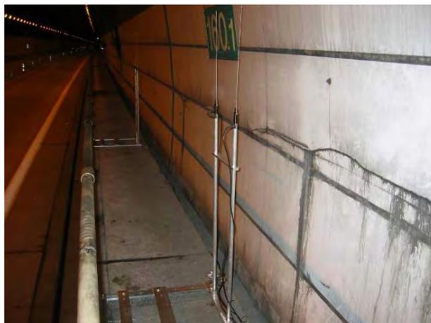
図-7 トンネル内アンテナ設置状況
