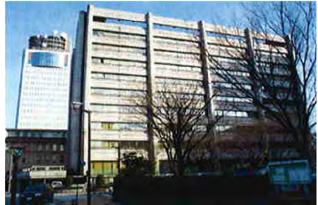
図-4 補強建物の外観
