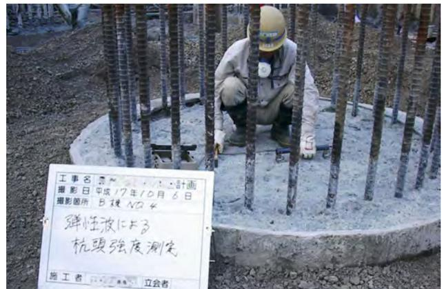
写真-2 杭頭の強度測定状況
