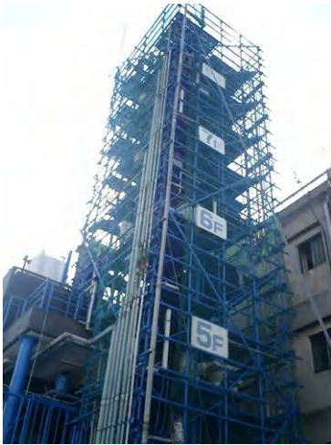
写真-1 排水実験タワー
