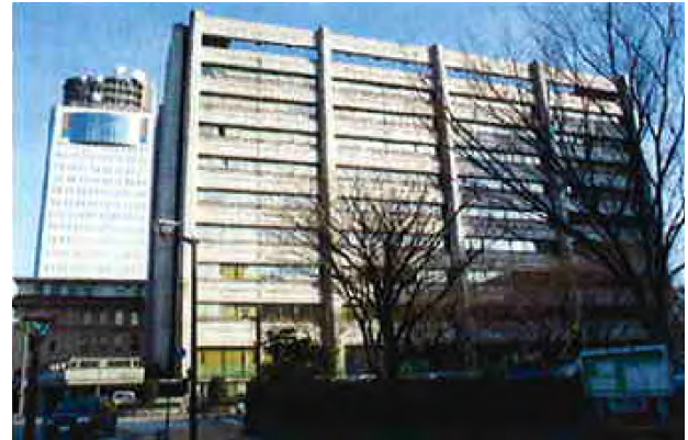
図-4 補強建物の外観
