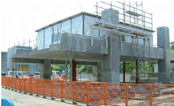
写真-1 実大架構試験体 (1F内装工事着手前)
