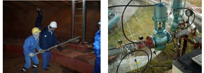
写真-5 人力加振状況
