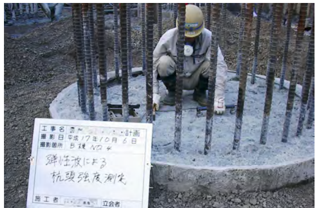
写真-2 杭頭の強度測定状況
