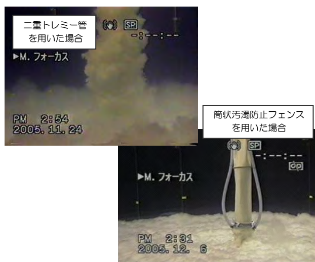
写真-1 濁質の拡散状況
