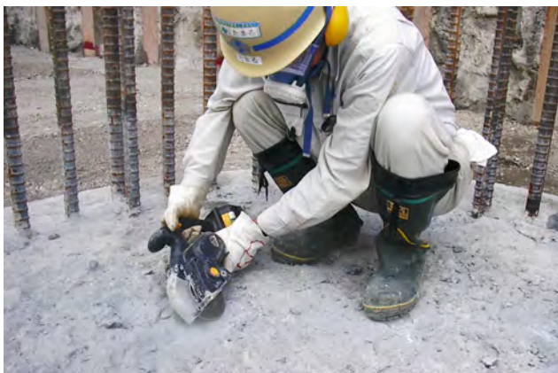
写真-1 杭頭の測定下準備状況
