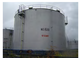
写真-3 外観写真
