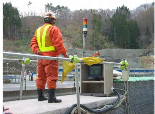
図-11 誘導員と誘導用設備
