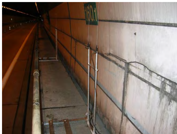
図-7 トンネル内アンテナ設置状況
