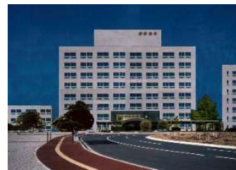
図-3 既存病院建物
