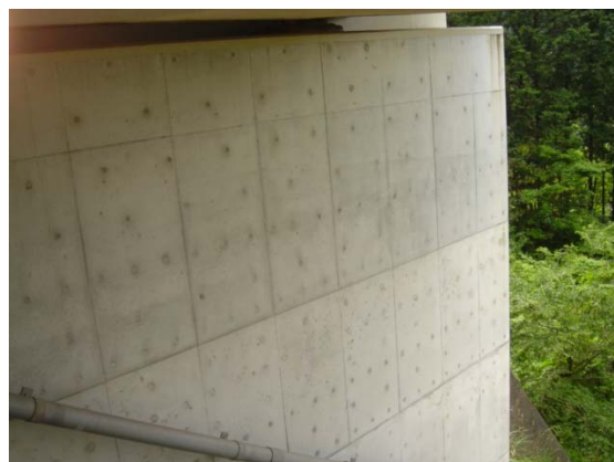
写真-2 塩害で劣化した橋台の断面修復材に使用した施工例
