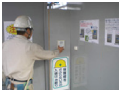
図-7 工区内セキュリティ管理 (認証による立入制限)
