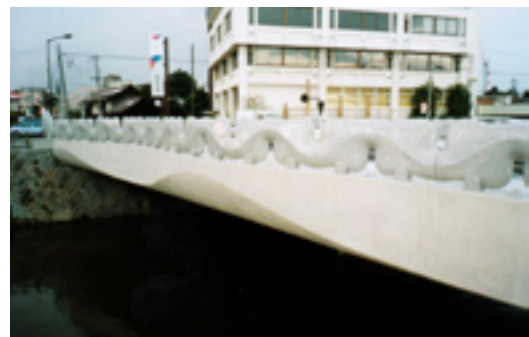
写真-1 低収縮コンクリートを用いた RC 張り出し床版
