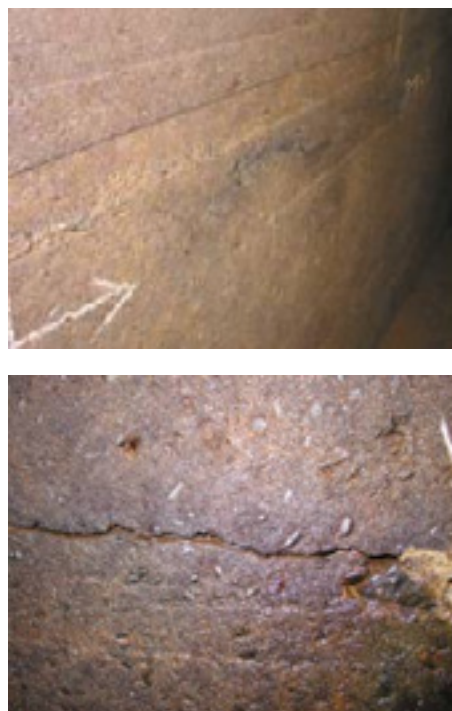
写真-1 点検で確認された構造ひび割れ
