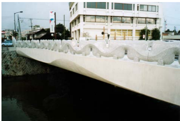
写真-1 RC 張出し床版への適用
