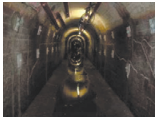
ロックボルトにより補修された極小断面トンネル
