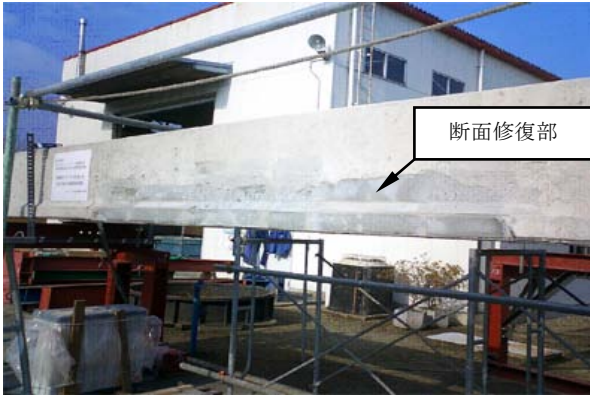
写真-3 塩害劣化を想定したPC桁の断面修復実験において、低収縮型高強度高流動コンクリートにより断面修復を行った状況 8)
