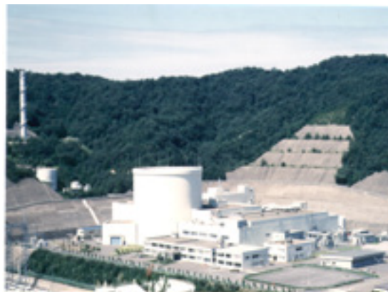
写真-1 原子炉廃止措置研究開発センター (通称：ふげん)
