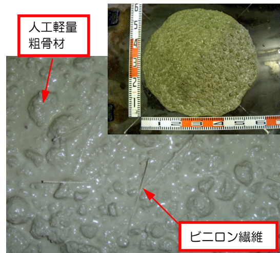
写真-1 はく落防止機能があるビニロン繊維を混入した高流動軽量コンクリート
