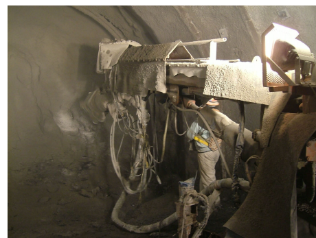
写真-2 吹付け状況
