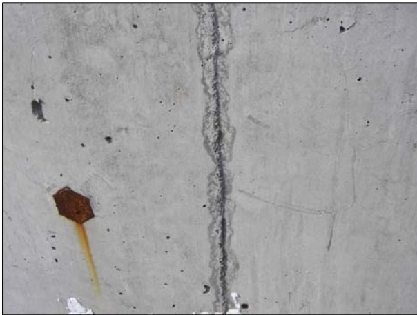
写真-3 計測対象の段差 (1 mm)
