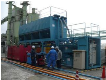
写真-1 混練りプラント
