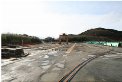
(d) 直線部配管状況
