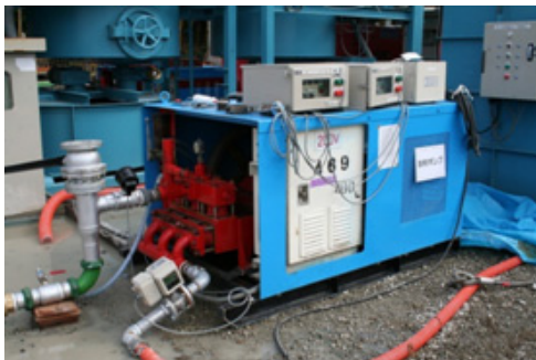
写真-3 B材圧送ポンプ設置状況
