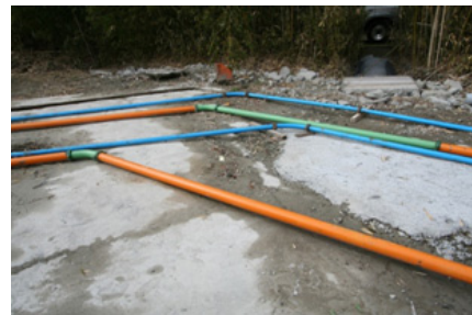
(c) 第 2 急曲部近傍配管状況
