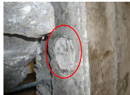
写真-3 鋼管充填コンクリートジベル (CFT1) 破壊状況
