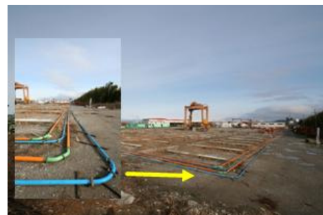
写真-3 急曲部近傍配管状況
