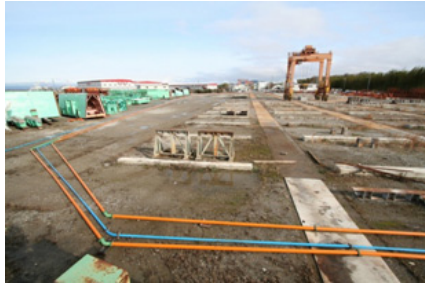
(e) 第3急曲部近傍配管状況
