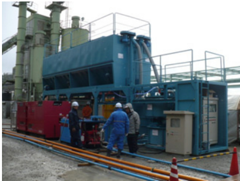
写真-2 混練りプラント設置状況
