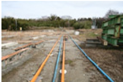
(f) 単直線部配管状況
