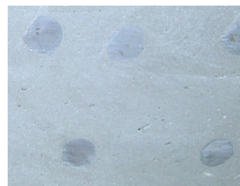
写真-3 鉄筋周りの充てん状況
