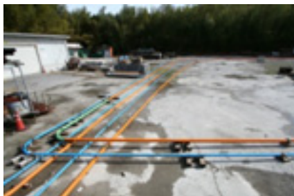
(h) 折り返し部配管状況
