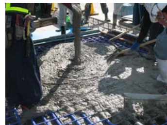
写真-2 打込み作業状況
