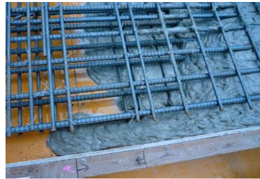
写真-5 模擬試験体の型枠内における流動状況
