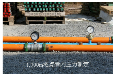
写真-7 配管内圧力計設置状況
