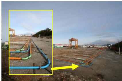
(g) 第4急曲部近傍配管状況
