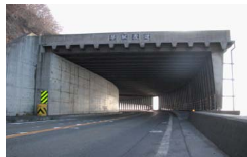
写真-1 ロックシェッドの例
