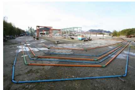
(b) 第 1 急曲部近傍配管状況
