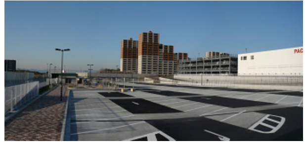
写真-1 田辺パーキングエリアの全景（完成後）
