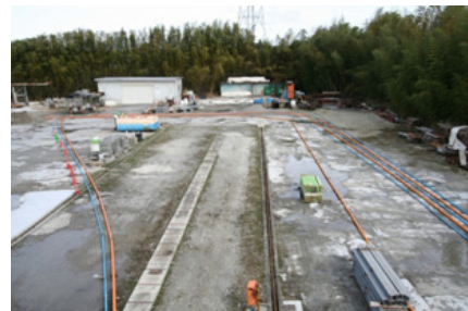
(a) 配管開始地点近傍配管状況
