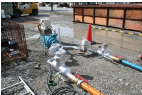
写真-4 終端部の合流 Y 字管とリミキシングポンプ
