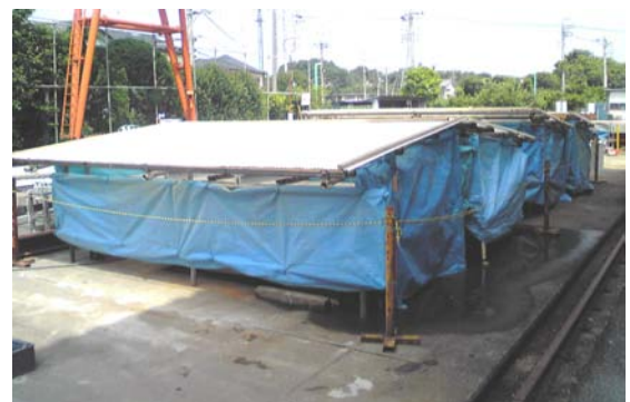
写真-2 養生状況
