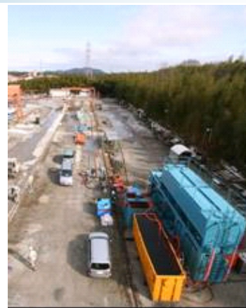
写真-2 混練りプラント全景
