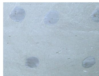
写真-3 鉄筋周りの充てん状況
