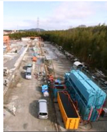
写真-2 混練りプラント全景
