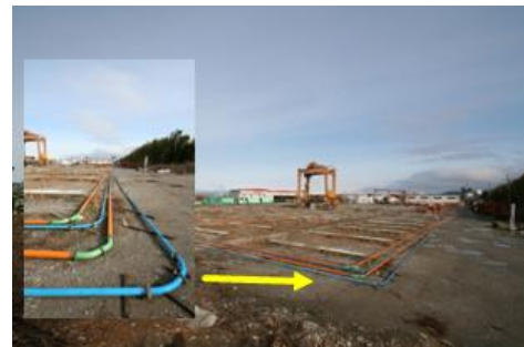
写真-3 急曲部近傍配管状況
