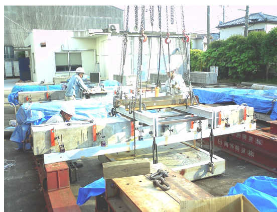
写真-1 載荷状況
