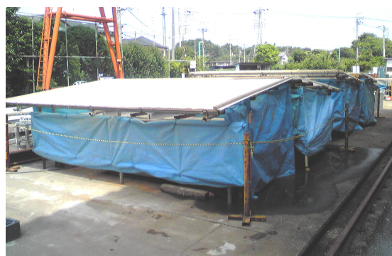
写真-2 養生状況
