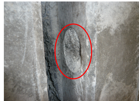
写真-2 コンクリートジベル (UFC) 破壊状況
