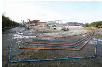
(b) 第 1 急曲部近傍配管状況
