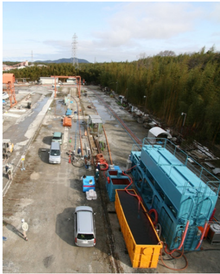
写真-1 混練りプラント設置状況（上部より俯瞰）
