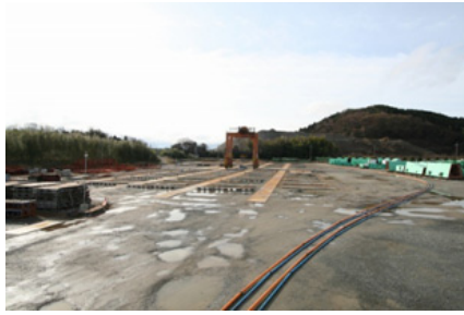
(d) 直線部配管状況
