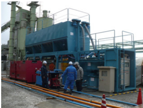
写真-2 混練りプラント設置状況
