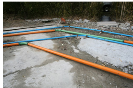
(c) 第 2 急曲部近傍配管状況
