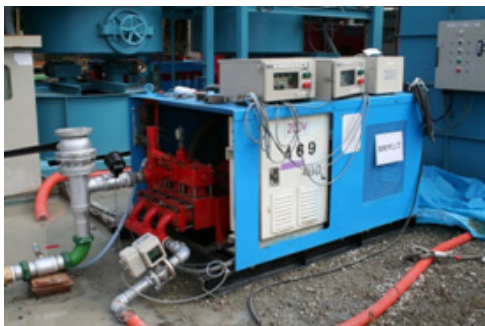
写真-3 B材圧送ポンプ設置状況
