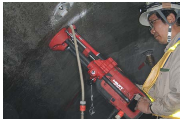
写真-3 検査孔削孔状況
