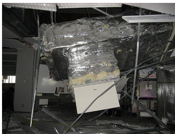
写真-4 空調ダクトの脱落
