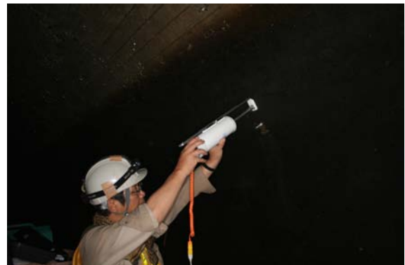
写真-4 棒形スキャナによる検査孔内壁の撮影状況
