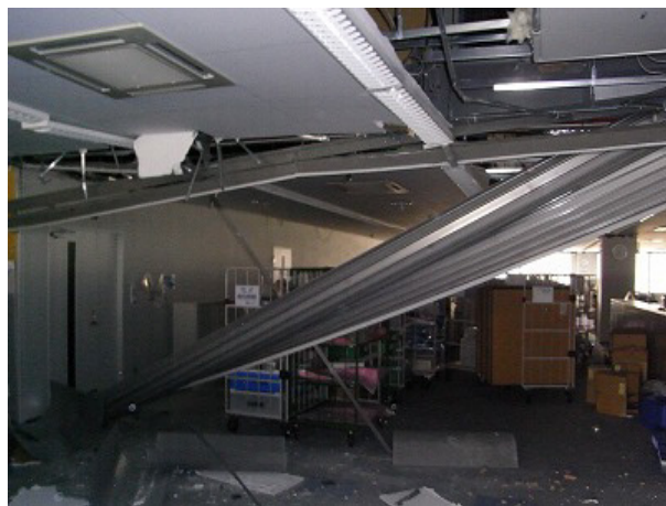
写真-2 天井下地とボードの脱落
