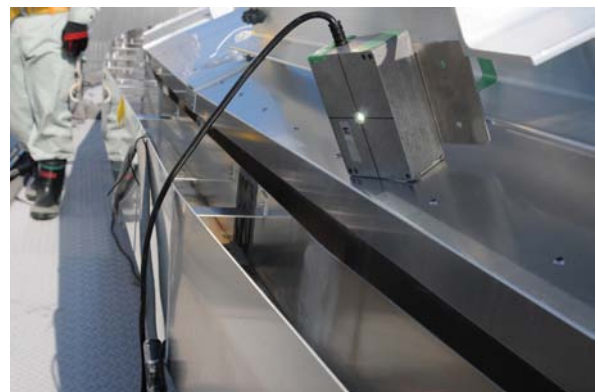
図-10 屋根端部へのLED光源設置状況
