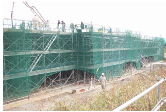
図-5 コンクリート打設状況
