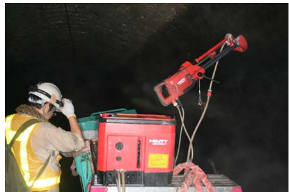
写真-2 小口径削孔システムの設置状況
