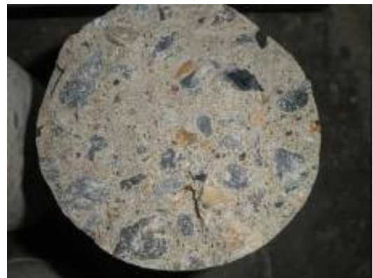
写真-3 破壊面の状況 (試験体⑤)
