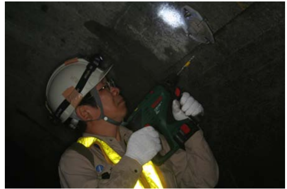
写真-1 小口径削孔機定着用アンカーの打設状況
