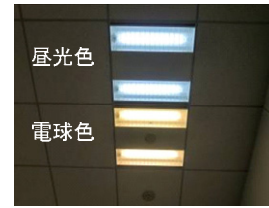
写真-3 二種類の蛍光灯
