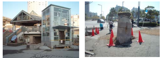
液状化による地盤沈下 マンホールの浮上り 写真-1 新浦安地区での被害
