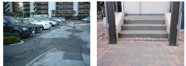
駐車場での噴砂と亀裂 改良・未改良範囲の境界での地盤沈下 写真-2 マンション敷地内での被害
