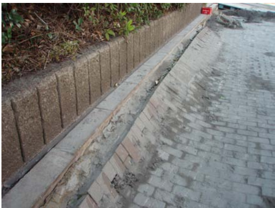
写真-6 新木場地域の歩道の沈下
