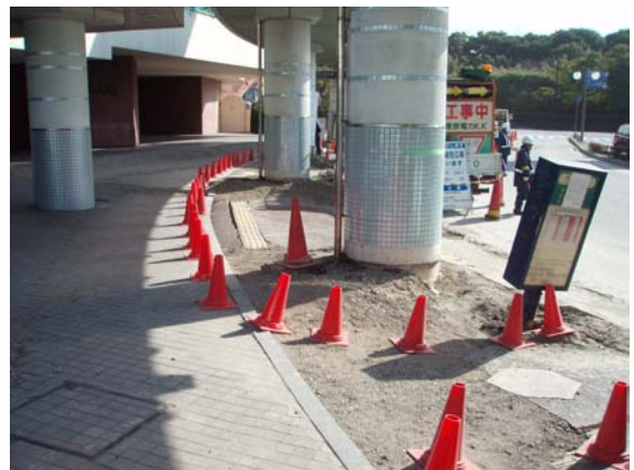
写真-9 舞浜駅前でのデッキ柱脚周辺の被害状況
