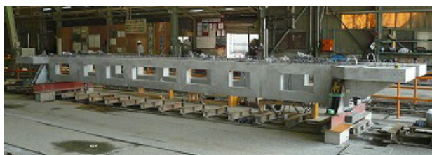
写真-3 試験体の仮置き状況
