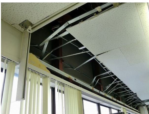
写真-3 吊天井と外壁取り合い部の損傷
