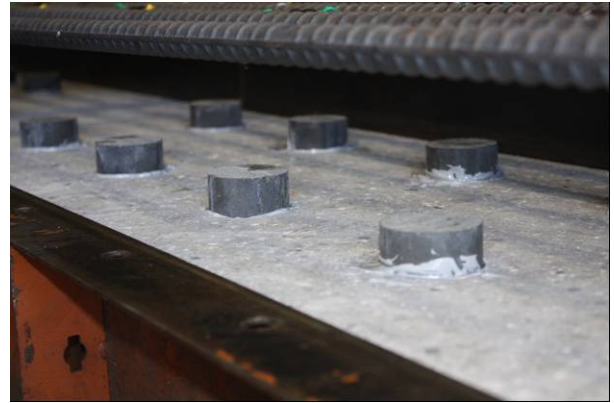
写真-1 モルタルジベルの配置
