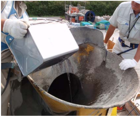
写真-1 トラックアジテータのドラム内への収縮低減剤の投入状況
