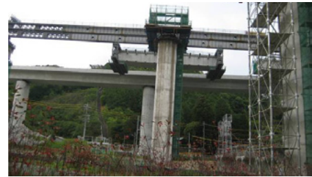
写真-1 施工状況
