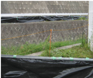
写真-2 暗幕の設置状況
