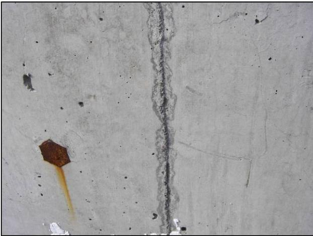
写真-1 計測対象となる段差 (1 mm)
