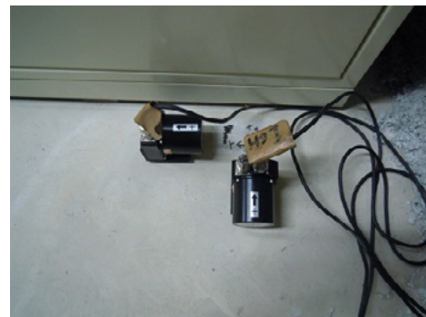
写真-1 センサーの設置状況
