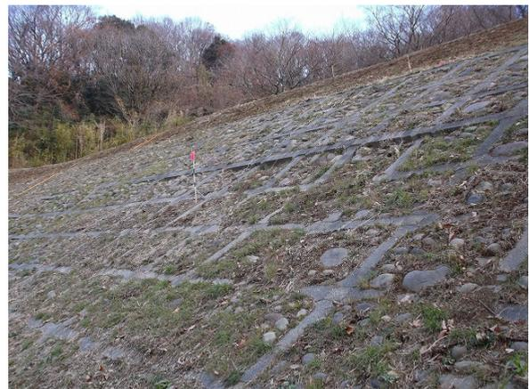
写真-1 法面枠破損，法面沈降・隆起
