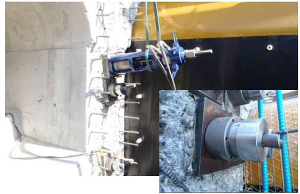
写真-5 PC 鋼棒の定着具設置状況
