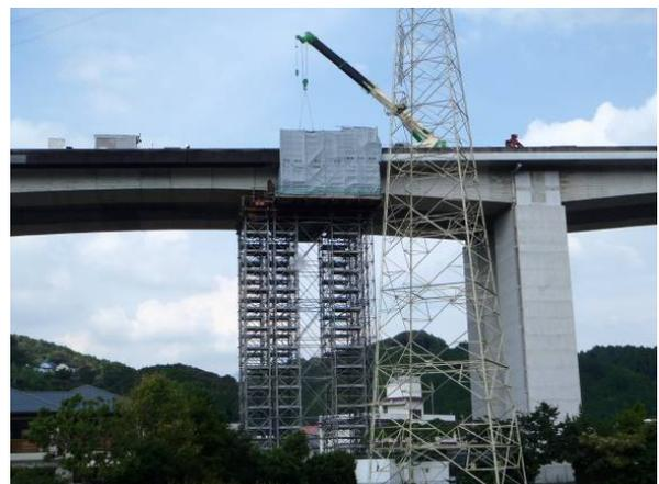
写真-4 ゲルバーヒンジ撤去工事状況
