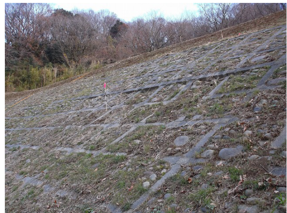
写真-1 法面枠破損，法面沈降・隆起
