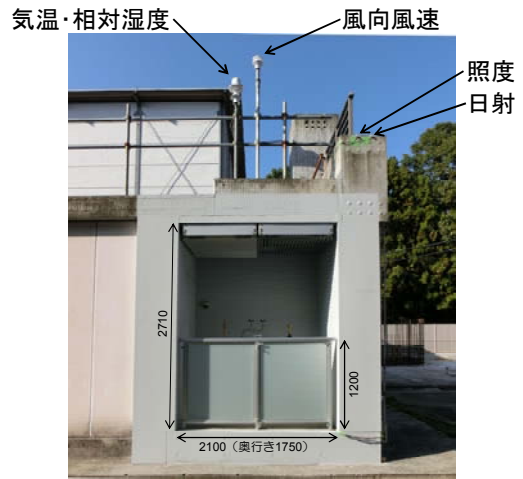
図-2 実験施設外観（ケース1）および外部測定項目
