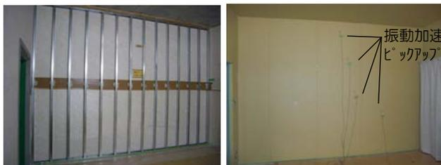
写真-1 ボード壁下地施工状況および振動測定状況
