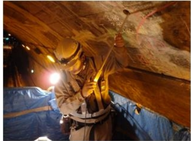
図-7 覆工背面空洞調査状況
