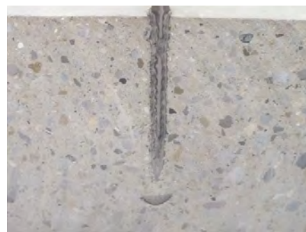
写真-2 引抜き試験後の突起部状況
