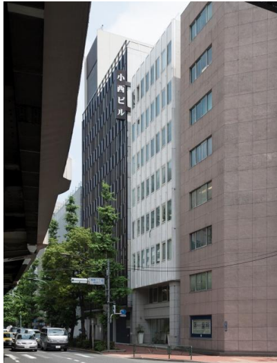
図-1 既存建物外観写真（中央白い建物）
