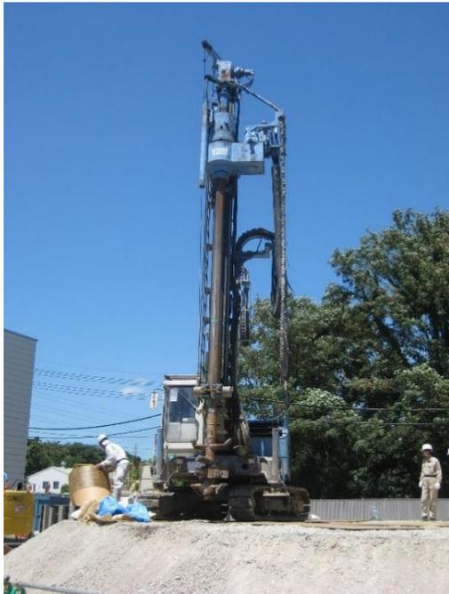
図-8 深層混合処理機
