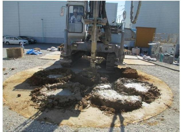
図-10 改良杭施工状況
