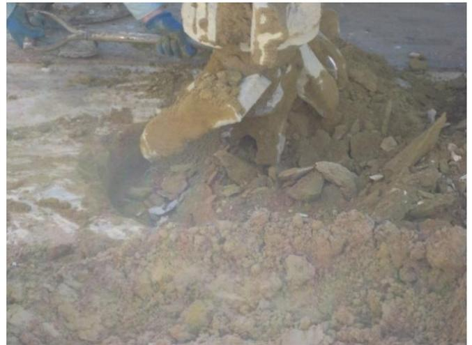
図-13 表層改良地盤掘削状況
