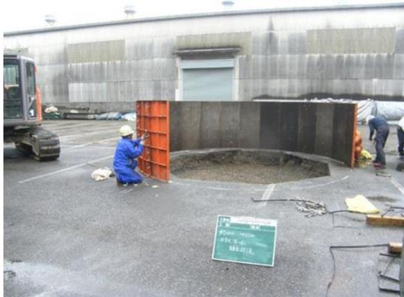
図-4 模擬地盤作製状況 (型枠組立)
