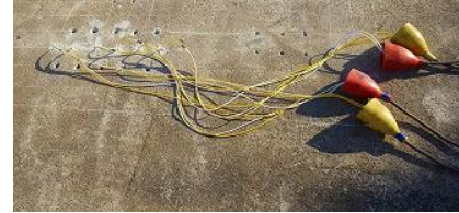
(b) 装薬・結線状況
