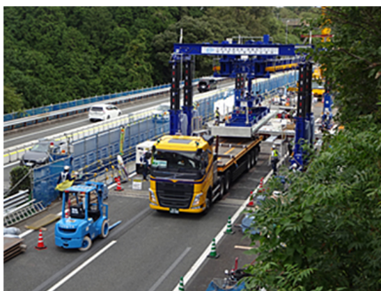
東名高速道路（裾野IC～沼津IC間） 床版取替工事
