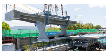
プレキャストセグメント架設状況
