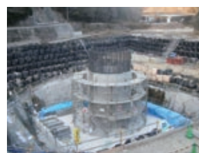
SPER工法を導入して河川内で施工を実施している現場の状況
