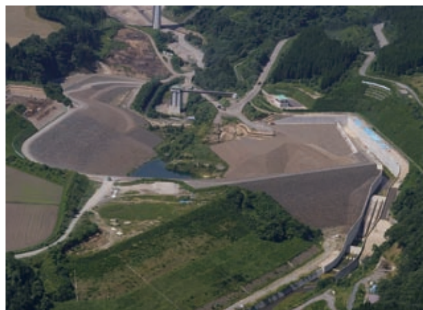
工事件名：上農水（整工）第3号 指改第53号工事他（指久保ダム） 発注者：青森県上北地域県民局様
