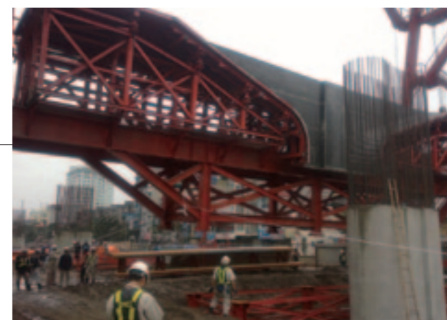
システム型枠組立状況
