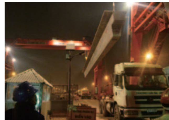
門型クレーンによる桁架設状況
