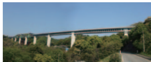
田久保川橋全景
