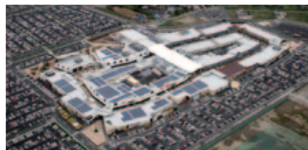
南西側鳥瞰(屋根に太陽光パネル)
