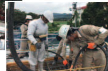
コンクリート打設状況
