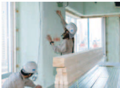
断熱材の吹付厚さの確認
