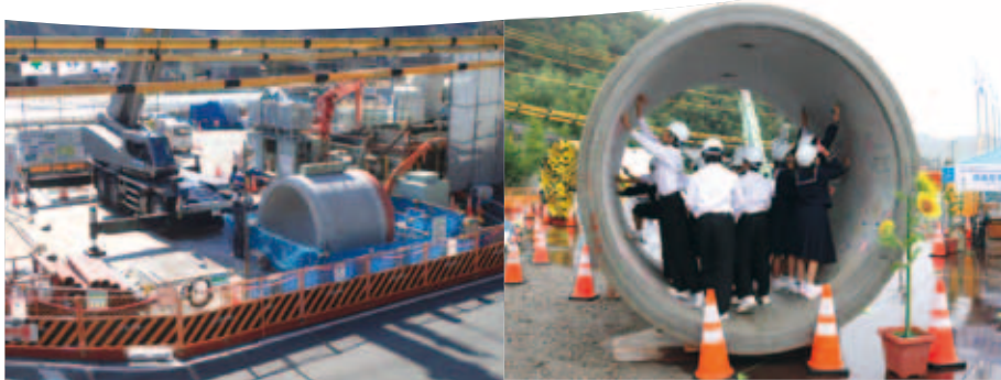
発達立坑基地全景
