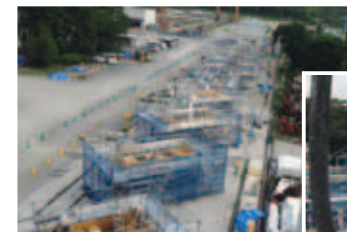
型枠組立状況全景
