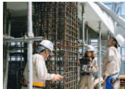
鉄筋の配筋状況の確認
