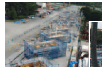
型枠組立状況全景
