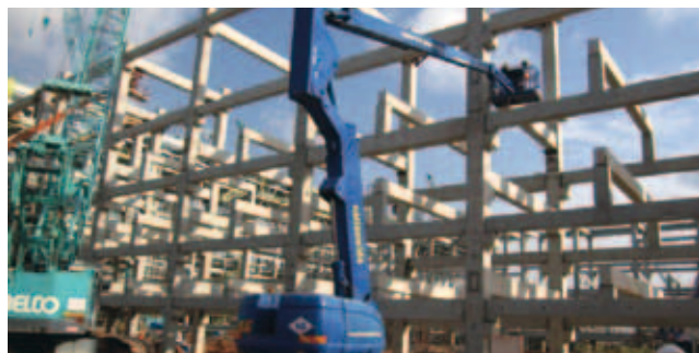
マレーシアでのプラント工場（パイプラック）の施行状況
