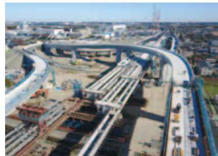
プレキャストU桁セグメント工法を採用したPC上部工工事
