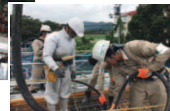
コンクリート打設状況
