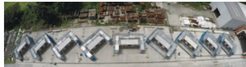
躯体打設完了全景
