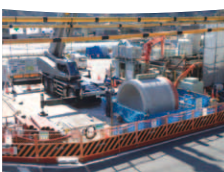
発達立坑基地全景
