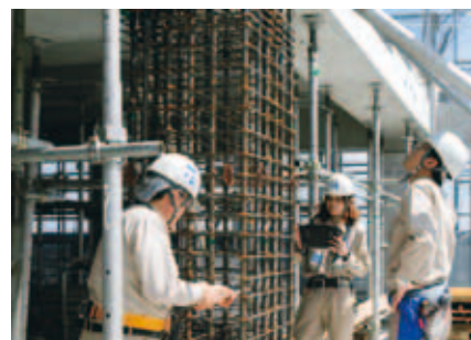
鉄筋の配筋状況の確認
