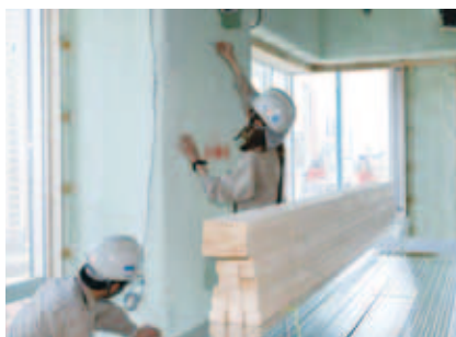
断熱材の吹付厚さの確認
