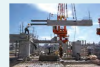
省人化・機械化施工 技術による生産性向上
