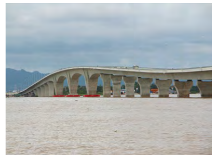
ディンビーヌ・カットハイ橋（ラックフェン港連絡路）／2017年竣工／ベトナム政府運輸省 第2事業管理局 発注
