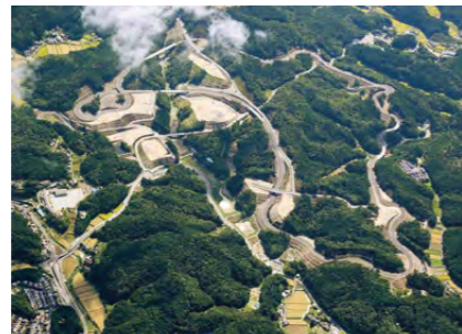
内陸用地造成事業 豊田・岡崎地区 中工区 整地工事/ 2017年竣工/愛知県企業庁 発注
