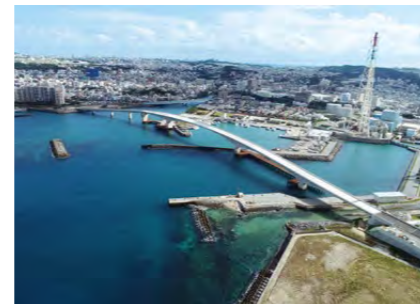
平成27年度牧港高架橋上部工(P4~P6)工事/ 2017年竣工/内閣府沖縄総合事務局開発建設部 発注
