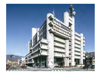
■ 2016 山梨文化会館 免震改修工事 テレビ局が入る文化施設を使用しながらの大規模免震改修工事
