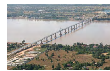
■ 2006 第二メコン橋(タイラオス) タイとラオスの国境を跨ぐ橋
